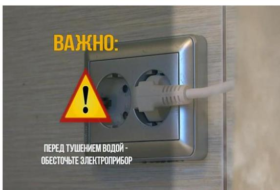
Не тушить водой горящие электропроводку и электроприборы, находящиеся под напряжением.
